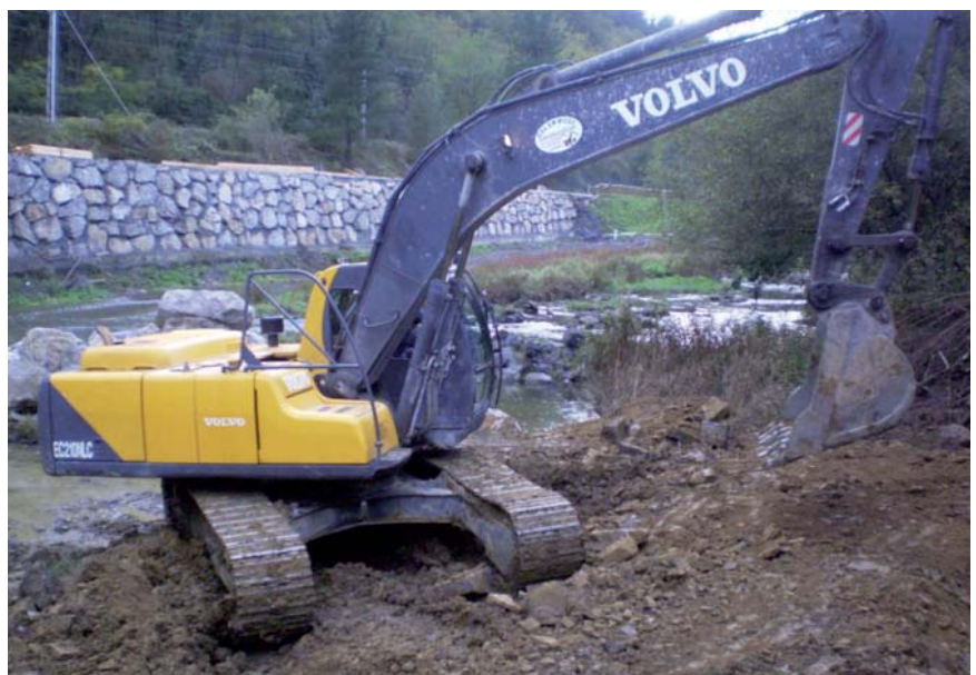
Reparación de un talud con retroexcavadora
