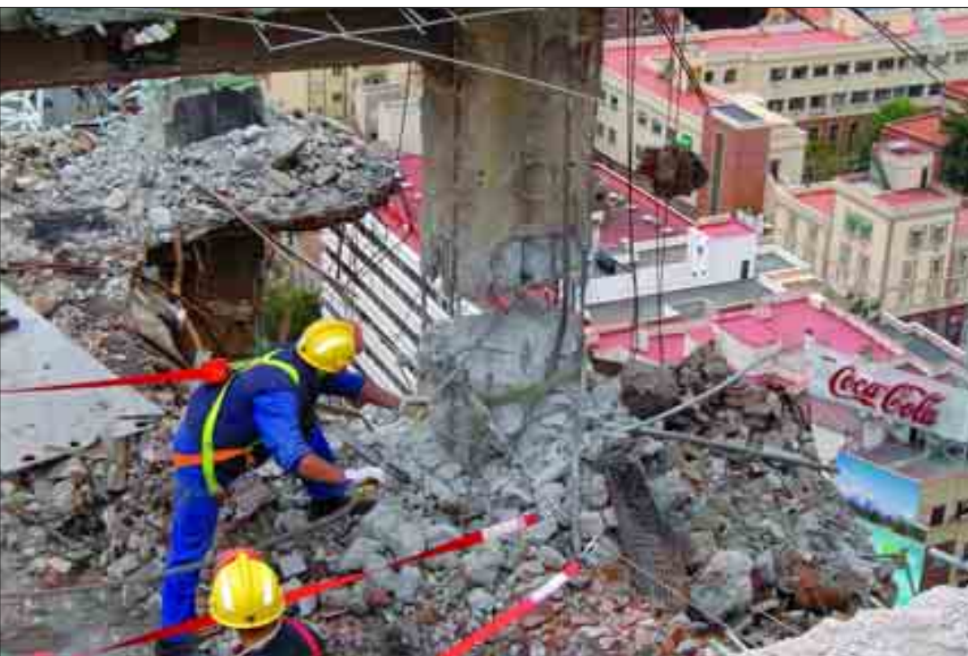
Proceso de demolición del edificio.
